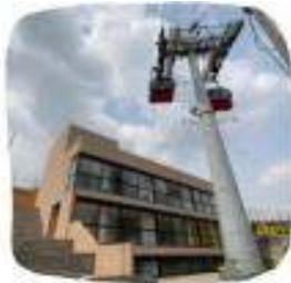
Centro Cultural Manitas (Ciudad Bolívar) Funcionamiento
